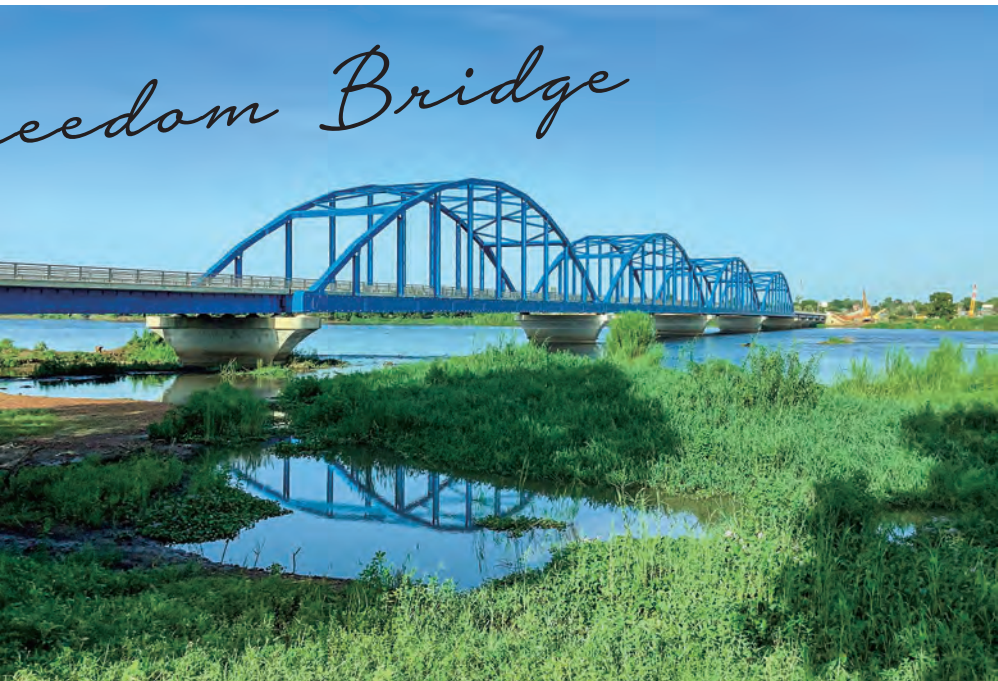
竣工した「Freedom Bridge」の全景。全長は560mを誇る(写真提供:大日本土木株式会社)
